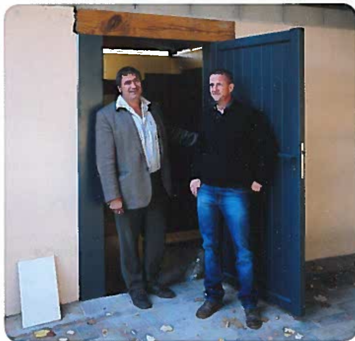
Jean-Michel Lamy, adjoint au maire aux côtés de Cédric Léontine, nouveau directeur des services techniques, surveillent attentivement le déroulement des travaux des nouvelles toilettes publiques situées près de la Capitainerie.
